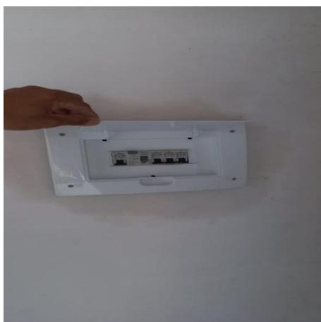
QUADRO DE DISTRIBUICAO DE ENERGIA DE EMBUTIR, EM CHAPA METALICA, PARA 3 DISJUNTORES TERMOMAGNETICOS MONOPOLARES SEM BARRAMENTO FORNECIMENTO E INSTALACAO
