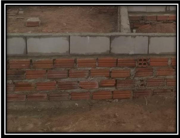
03.03 - CINTA DE AMARRAÇÃO DE ALVENARIA MOLDADA IN LOCO COM UTILIZAÇÃO DE BLOCOS CANALETA. AF\_03/2016
