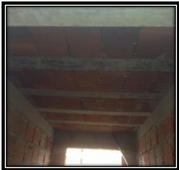
05.03 - CINTA DE AMARRAÇÃO DE ALVENARIA MOLDADA IN LOCO COM UTILIZAÇÃO DE BLOCOS CANALETA.
