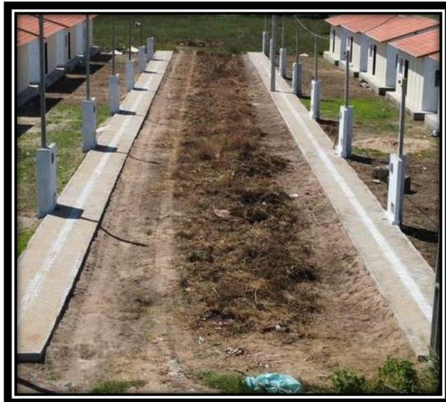
3.07- RAMPA PARA ACESSO DE DEFICIENTES, EM CONCRETO SIMPLES FCK=25MPA, DESEMPOLADA, COM PINTURA INDICATIVA EM NOVACOR, 02 DEMÃOS
