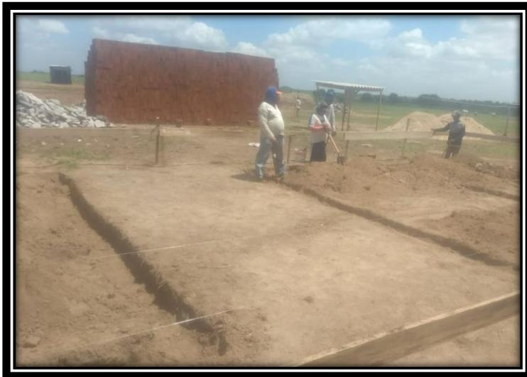
02.03 - ATERRO MANUAL COM AREIA PARA ATERRO E APILOADO COM SOQUETE EM CAMADAS DE 20 CM. R\_11/2019
