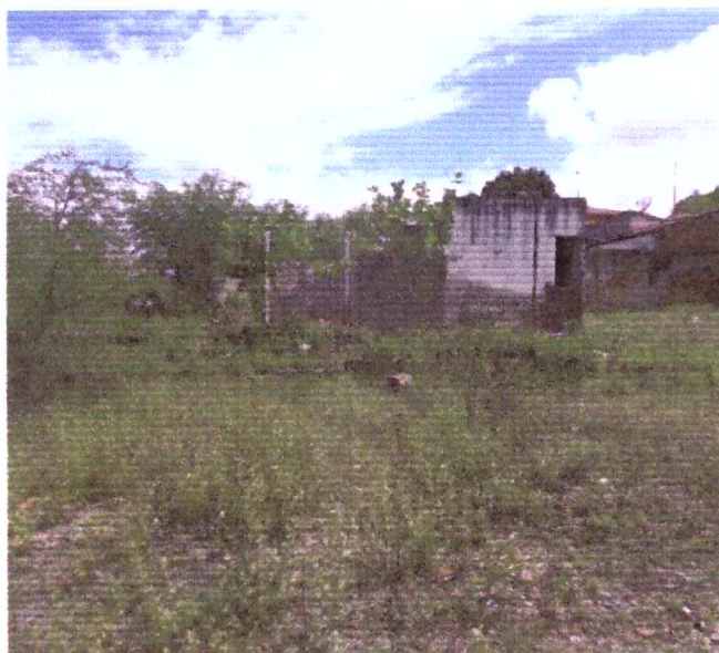
IMÓVEL DANIFICADO FOTO 13
