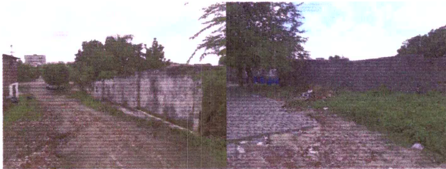
VISTA DO MURO EXTERNO FOTO 1 - 2
